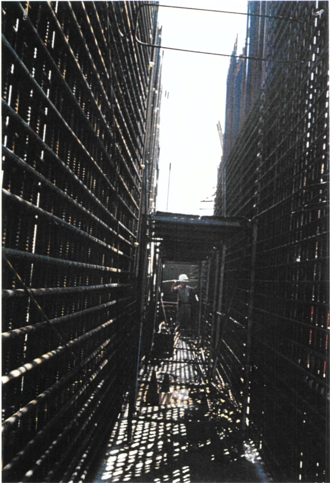
Bewehrung - Reaktoraußenwand von +6,00 m bis +11,00 m (24.08.1997)
